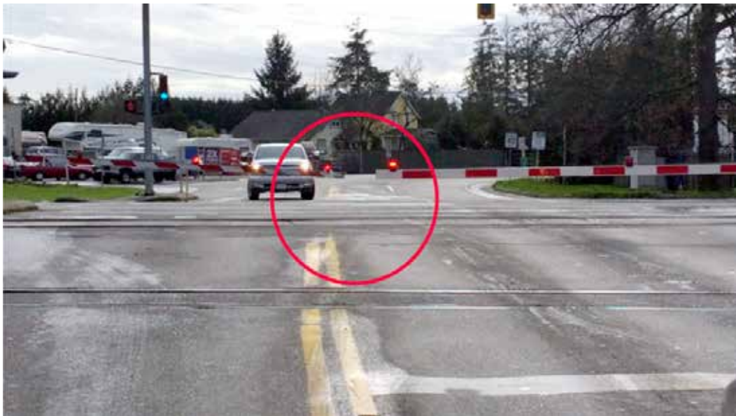
Figure 5. Lisse de la barrière dépassant la ligne médiane
