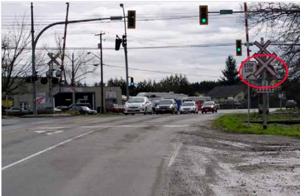
Figure 6. Système d'avertissement de passage à niveau partiellement masqué à la circulation en direction est approchant du passage à niveau
