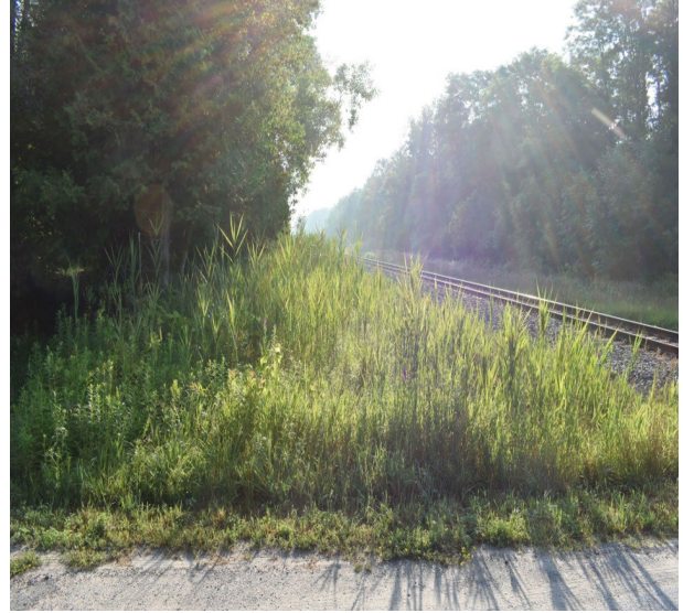
Figure 3. Vue vers le sud-est du passage à niveau du chemin Hunt du CPKC, d'une position semblable à celle du conducteur d'un véhicule qui circule vers le sud (Source : BST; photo prise le 16 juillet 2025 dans des conditions environnementales similaires aux conditions présentes au moment de l'événement)
