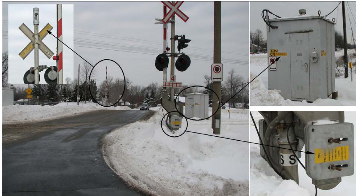
Photo 3. Emplacement de l'information sur les numéros d'urgence au passage à niveau, vu du sud
