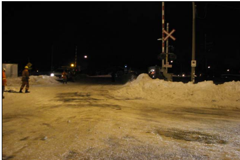
Photo 1. Bancs de neige à l'angle sud-est du passage à niveau
